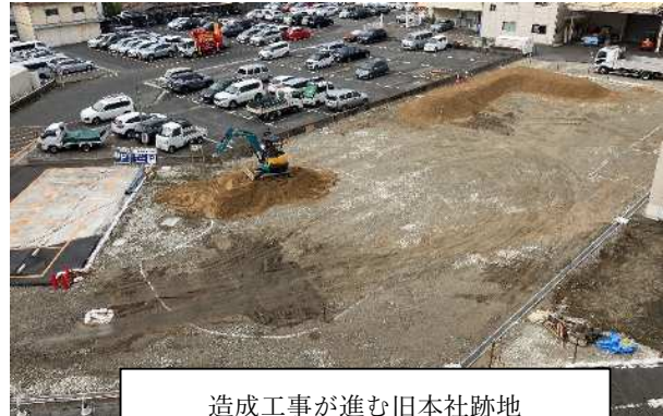
造成工事が進む旧本社跡地
