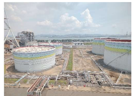
燃料油タンク
